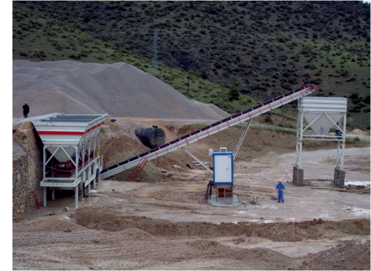
AYDIN İNŞAAT BOYABAT
